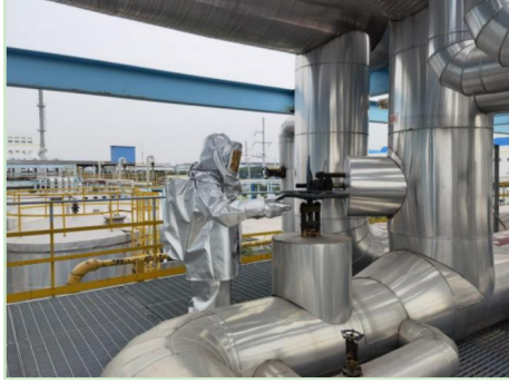
常州生产基地开展高温热媒泄漏应急 实战演练
